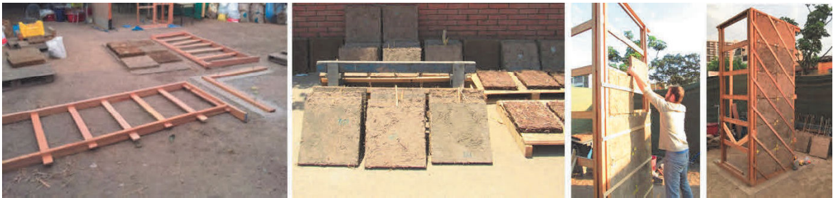
Figura 4. Experimentación constructiva (crédito: Archivo de proyecto, 2018).
