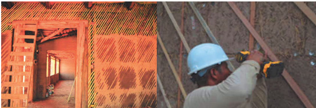
Figura 7. A la izquierda, ejemplo contemporáneo de contención con madera (fuente: www.archdaily.pe ); a la derecha, colocación de diagonales en el sistema propuesto (fuente: Archivo del Proyecto, 2019).
